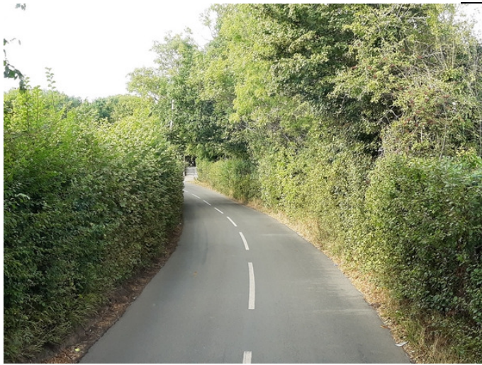
Die Straße zu (Fahrbahnbreite je Line, ca. 2m)
